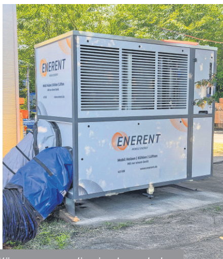
Das Bild zeigt eine Wärmepumpe, die eine Lagerhalle kühlt. Aber auch für Einfamilienhäuser kommen Wärmepumpen zur Temperaturregulierung im Sommer infrage. Foto: DJD/ENERENT
